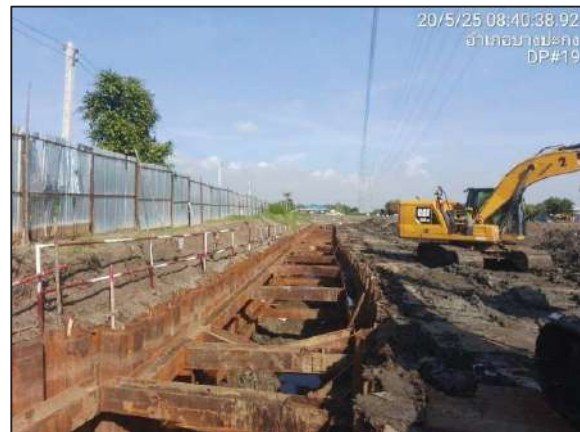
ฉ) การติดตั้ง Sheet Pile ป้องกันดินถล่ม
