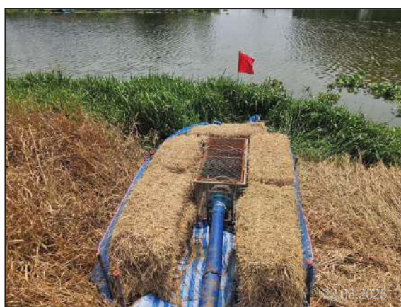
ช) การติดตั้งตะแกรงตาถี่และถุงกรอง บริเวณปลายท่อระบายน้ำทิ้งเพิ่มเติม เพื่อทำการดักตะกอนแขวนลอย
