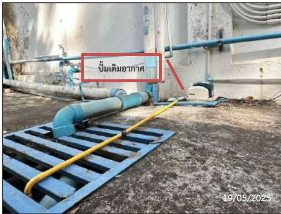
ถังบำบัดน้ำเสียแบบเติมอากาศบริเวณสำนักงานชั่วคราว
