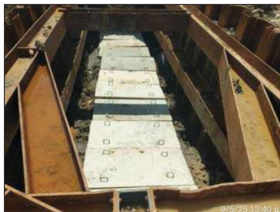
การวางแผนคอนกรีตเหนือแนวท่อ
