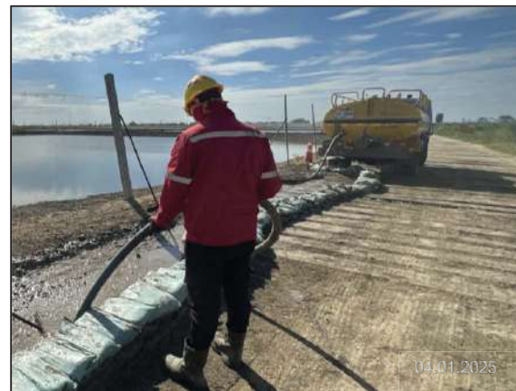
ง) รถดูด (Vacuum) สูบโคลนโซเดียมเบนโทไนต์ตามแนวที่มีการทะลักขึ้นมา
