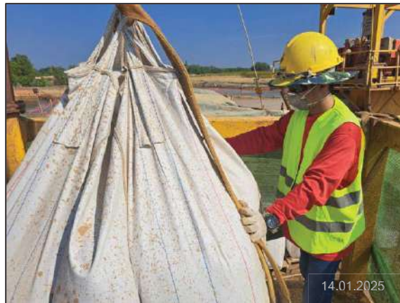
ฉ) การผสมโซเดียมเบนโทไนต์เพื่อใช้ในการเจาะลวด ให้พอดีกับปริมาณงานเจาะลวด
