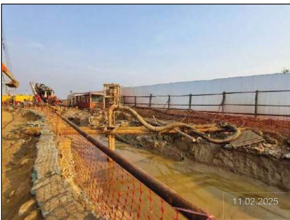
รูปที่ 2-16 การวางถุงทรายหรือจัดทำคันดินกันรอบพื้นที่บ่อรับ-ปล่อย
