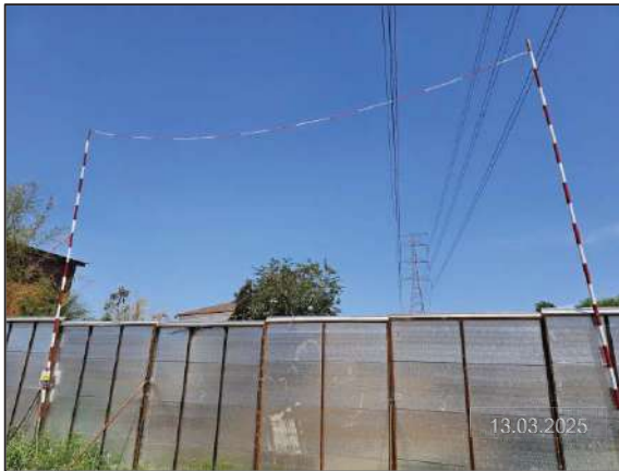
ข) การติดตั้ง Goal post เป็นสัญลักษณ์ระยะปลอดภัยจากสายส่งไฟฟ้าแรงสูง
