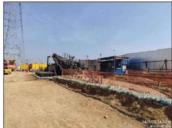
รูปที่ 2-15 การติดตั้ง Sheet pile ป้องกันการพังทลายของดินบริเวณบ่อรับ-ปล่อย
