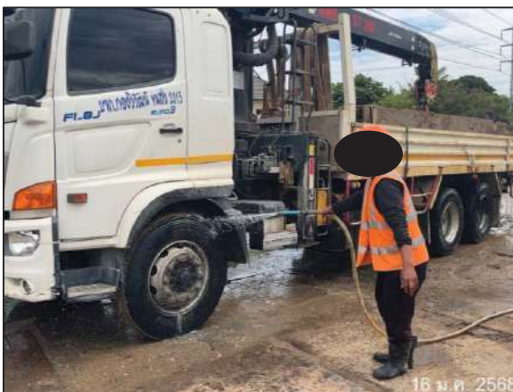
รูปที่ 2-9 การจัดทำพื้นที่ล้างล้อทำความสะอาดเศษดินและเศษโคลนที่ติดกับล้อรถ ก่อนออกจากพื้นที่เก็บท่อ (Stock Yard)
