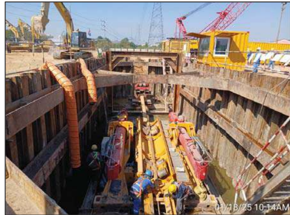
รูปที่ 2-15 การติดตั้ง Sheet pile ป้องกันการพังทลายของดินบริเวณบ่อรับ-ปล่อย
