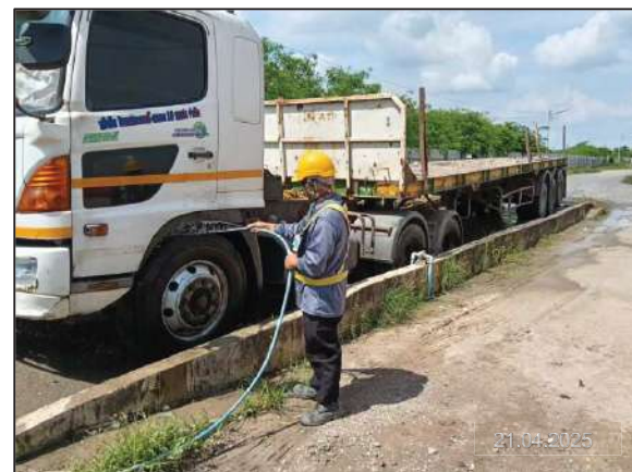
รูปที่ 2-9 การจัดทำพื้นที่ล้างล้อทำความสะอาดเศษดินและเศษโคลนที่ติดกับล้อรถ ก่อนออกจากพื้นที่เก็บท่อ (Stock Yard)
