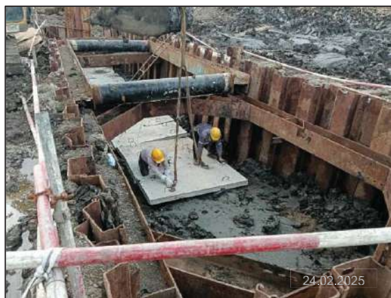
การวางแผนคอนกรีตเหนือแนวท่อ
