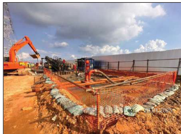
รูปที่ 2-16 การวางถุงทรายหรือจัดทำคันดินกันรอบพื้นที่บ่อรับ-ปล่อย
