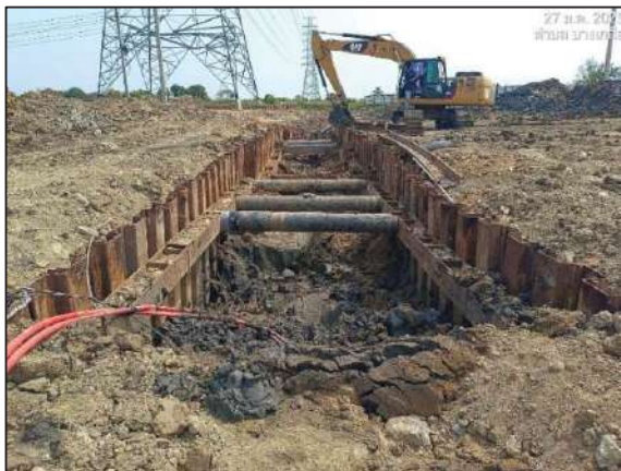
ฉ) การติดตั้ง Sheet Pile ป้องกันดินถล่ม
