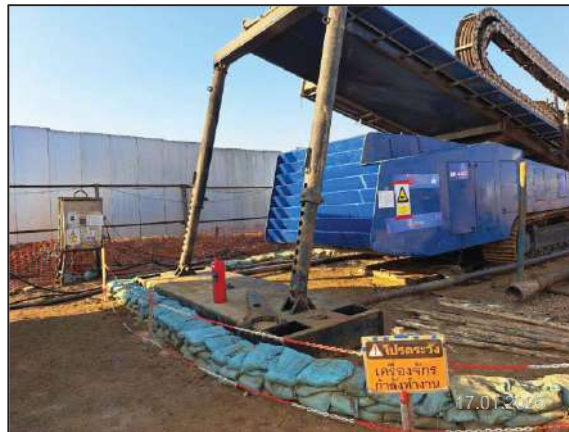
ก) การจัดวางถุงทรายหรือจัดทำคันดินกันโดยรอบบ่อรับ-ปล่อย
