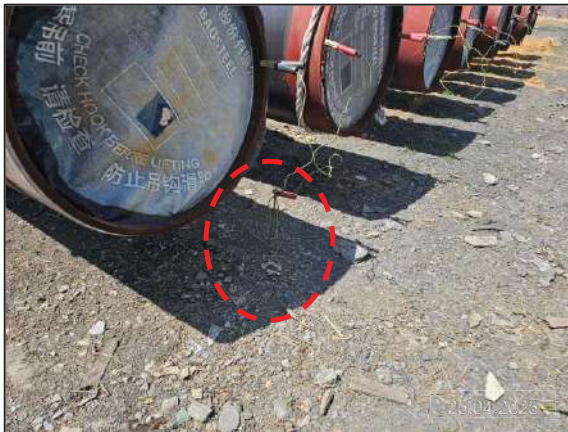
ค) การต่อสายดินกับท่อที่วางเรียงได้ส่งไฟฟ้าแรงสูง โดยใช้ปากคิบบริเวณที่จับ (Clamp) กับท่อส่งก๊าซธรรมชาติ
