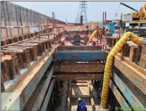
รูปที่ 2-15 การติดตั้ง Sheet pile ป้องกันการพังทลายของดินบริเวณบ่อรับ-ปล่อย
