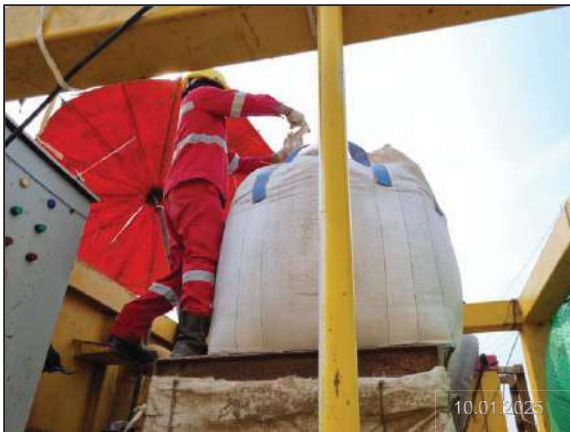
ฉ) การผสมโซเดียมเบนโทไนต์เพื่อใช้ในการเจาะลวด ให้พอดีกับปริมาณงานเจาะลวด
